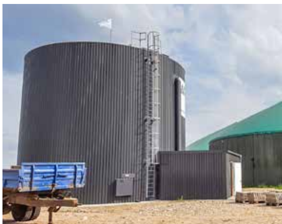
Bei einem Betrieb der Anlage zu Spitzenbedarfszeiten nimmt der große Speicher die anfallende Wärme auf.
