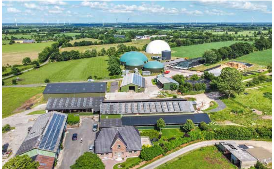
Regenerative Speicherkraftwerke wie die Biogasanlage Gottburg in Jörl sind durch ihre Auslegung flexibel und liefern bedarfsorientiert Strom und Wärme. Foto: Agrarservice Lass
