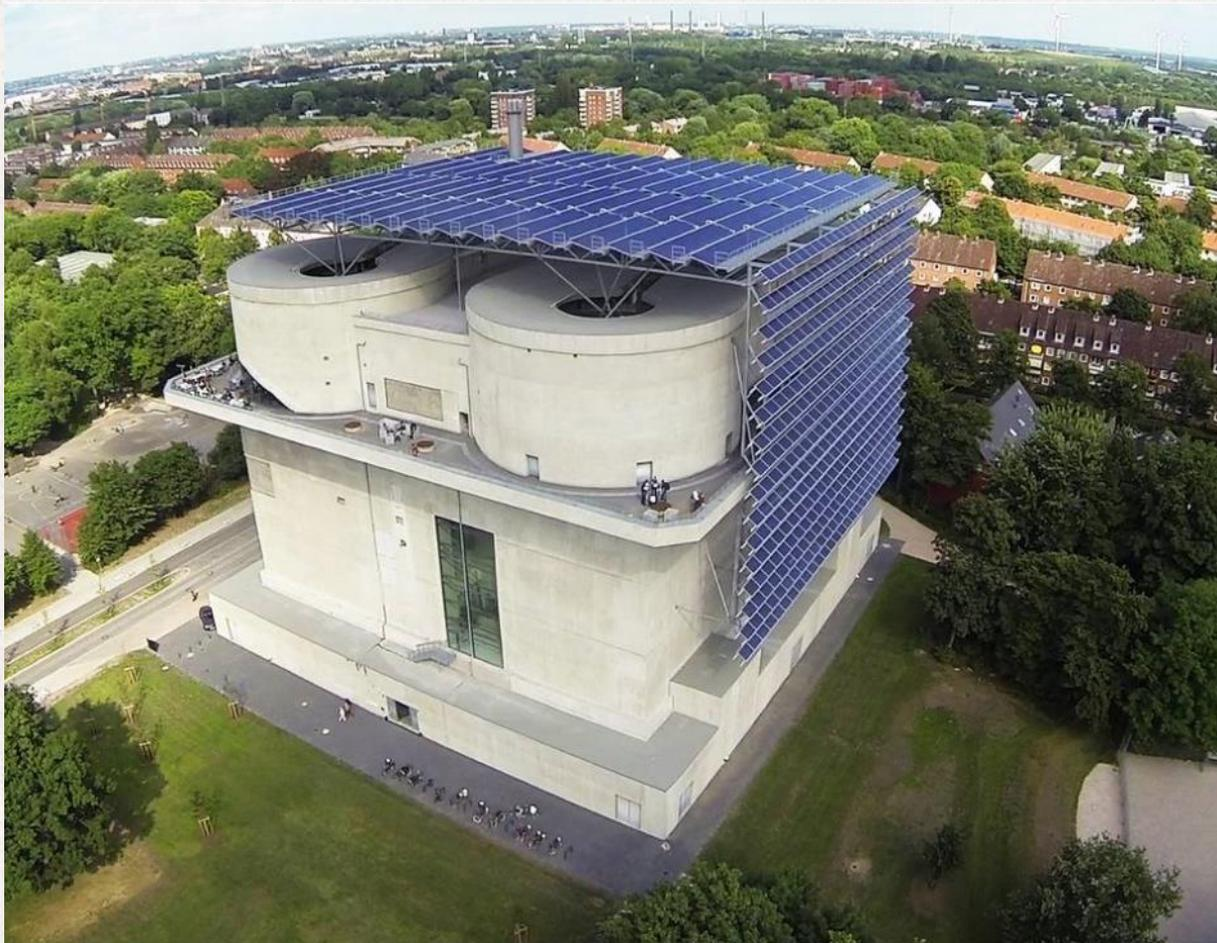
**Der Flakbunker in Wilhelmsburg wurde zu einem regenerativen Kraftwerk umgebaut, um die angrenzenden Quartiere mit Wärme zu versorgen**
